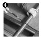
次にステンレスジャバラホース① に印をした箇所を金属用のこぎり などで切断して下さい。
